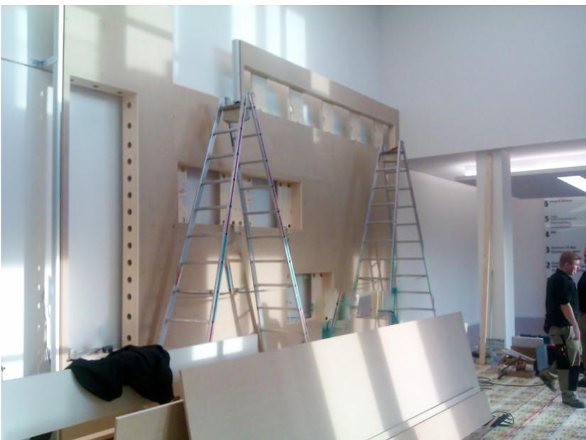
Um die Monitore flächenbündig mit der Wand abzuschließen und der verbauten Technik genug Luft zur Kühlung zu verschaffen, empfahl sich eine Unterkonstruktion.
